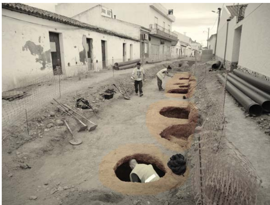
Vista sul da escavação da área de armazenagem, Rua de São Pedro, Alvalade.
