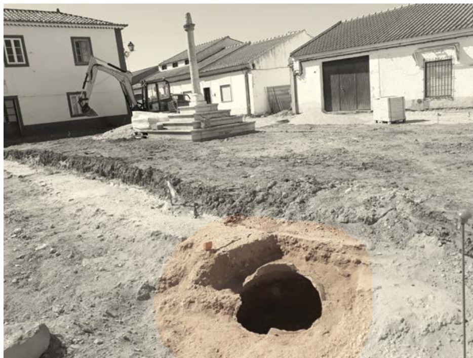
Vista sudeste da escavação da talha, Praça D. Manuel I, Alvalade.
