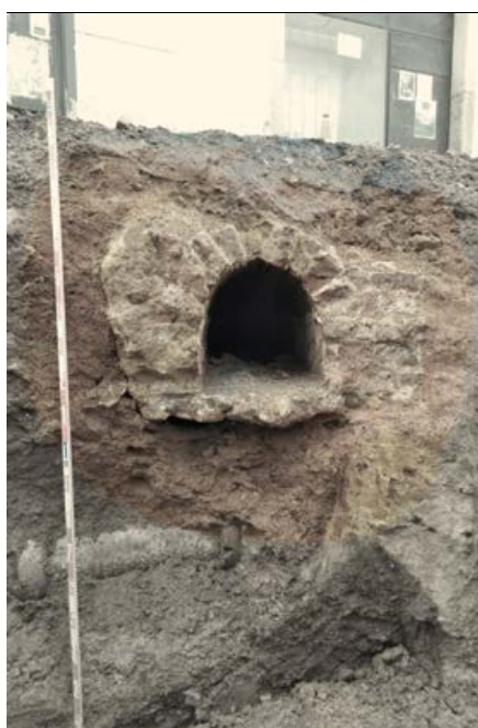
Vista da secção da galeria de águas, documentada na Rua 31 de Maio, Alvalade.
