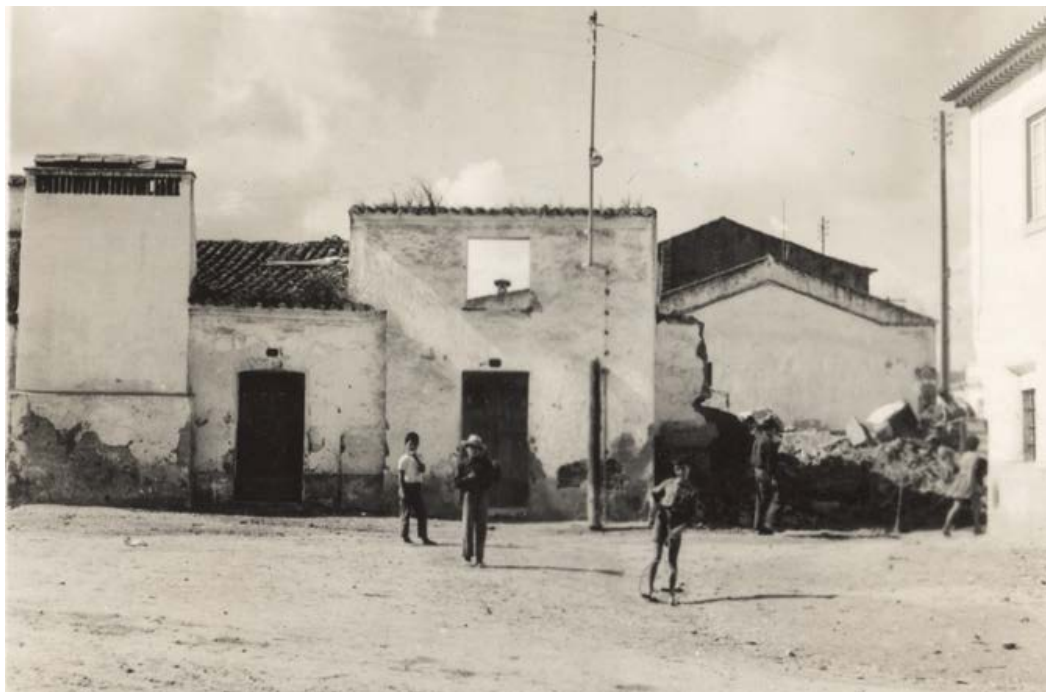
Vista das fachadas das casas documentadas durante a escavação, Praça D. Manuel I, Alvalade. Imagem cedida por Ângela Atayde e Ana Paula Atayde.
