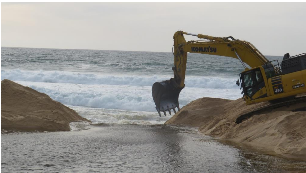
Foto 2. Abertura da Lagoa de Santo André ao mar, recorrendo a maquinaria (Foto: João Carlos Farinha).
