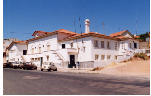
Vista geral do edifício da Casa do Povo de Santiago do Cacém (fotografia: José Matias, S.d., CMSC).
