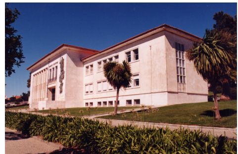
Vista geral do edifício Tribunal de Santiago do Cacém (fotografia: José Matias, S.d., CMSC).
