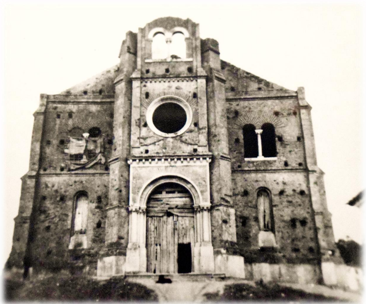
Igreja de Nossa Senhora de Abela em fase de construção [Fotografia]. 1947. PT/AMSC/IMHIST/col. SFCA. Imagem cedida por: Sporting Futebol Club Abelense.
